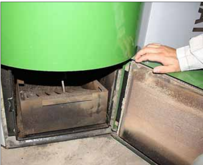
Asla van een verwarmingsketel die met houtpellets werkt
